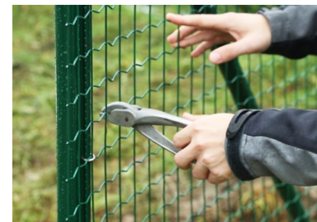
napnutie pletiva - krepovacími kliešťami
